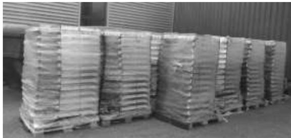
Les structures sont livrées préassemblées, et déchargées au transpalette ou manuscopique ; Une palette a une masse de 200kg maximum et une hauteur de 2m ; une protection type plaque OSB sera posée sur l'étanchéité afin de ne pas risquer d'endommager l'étanchéité. Les structures seront ensuite positionnées sur la toiture avant soudure.
