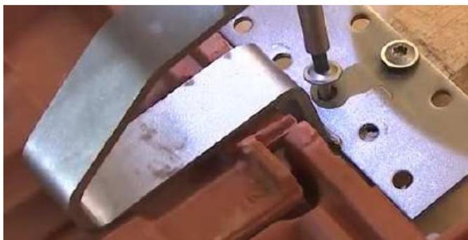
Figure 27: Mise en position du crochet sur tuile meulée
