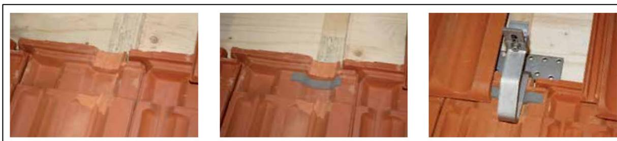
Figure 28: Pose d'une bande d'étanchéité
