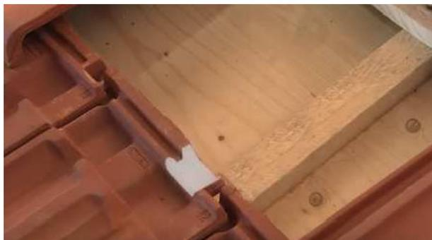
Figure 26: Partie de tuile à retirer
