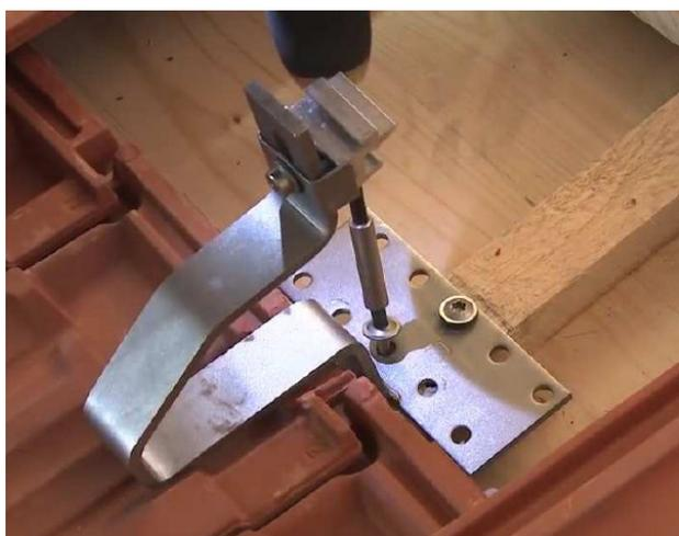
Figure 21: Fixation d'un crochet par deux vis
