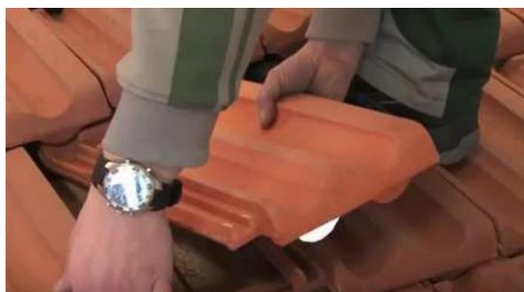
Figure 30: Partie de tuile à retirer
