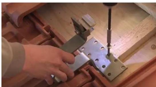
Figure 1: Pose d'un crochet Rapid2+ 45
